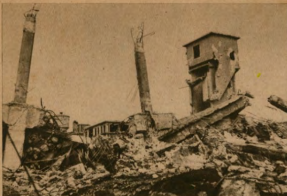
屋家トーリクンコ筋鐵たし潰全 9
